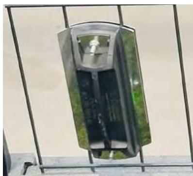
Zdj. 2. Przykład detektorów bezprzewodowych instalowanych na ogrodzeniu Źródło: materiały własne.
